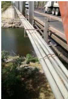
Fotografía 8. Tuberías de servicios públicos que utilizan el puente como soporte.
