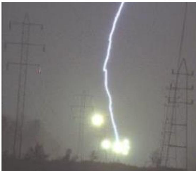
Figura 27 – Incidência de descarga atmosférica sobre linha de transmissão
