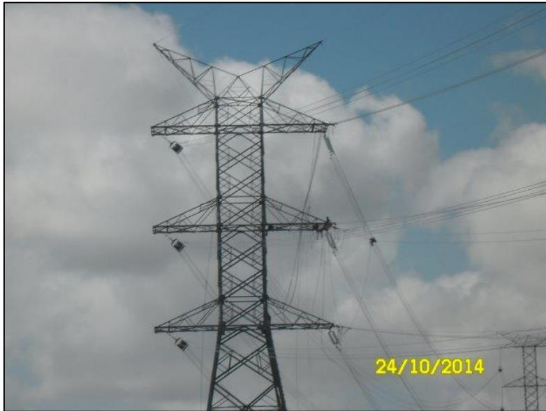
*Foto 2: Torre FD45, de ancoragem grande ângulo/ terminal, em circuito duplo vertical da LT 525 kV Marmeleiro – Povo Novo.*
