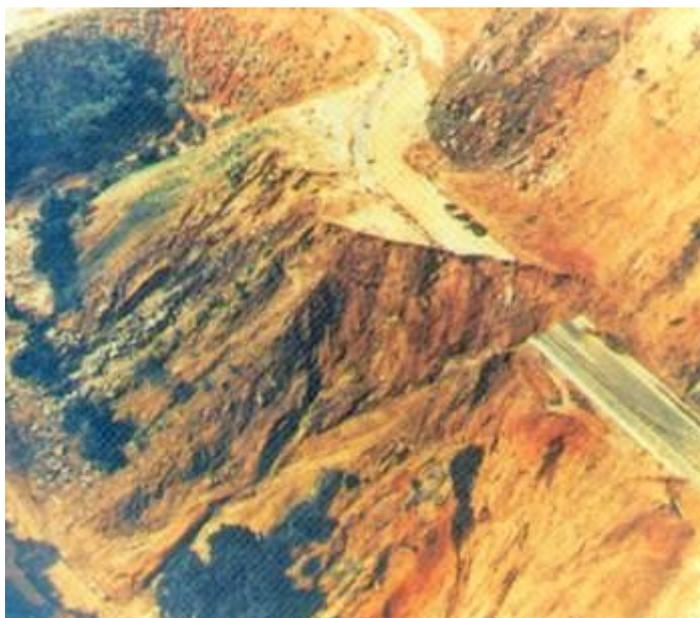
Foto 07: Observa-se na foto a ação do homem através de o corte de um talude, e na sequência o escorregamento do tipo cunha (Montgomery, 1992).
