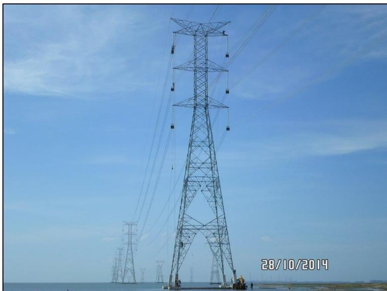
Foto 1: Torre SD2, de suspensão em circuito duplo vertical da LT 525 kV Marmeleiro – Povo Novo.
