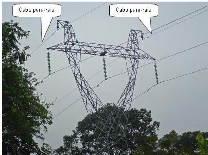
Figura 13 – Torre com dois cabos pára-raios instalados, sendo um em cada pontina da torre
