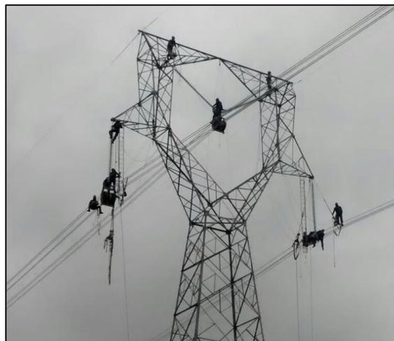
*Foto 3: Torre SL2, de suspensão, em circuito simples da LT 525 kV Salto Santiago – Itá C2, observa-se a equipe trabalhando na conexão da cadeia de isoladores com os cabos condutores e também nos para-raios.*
